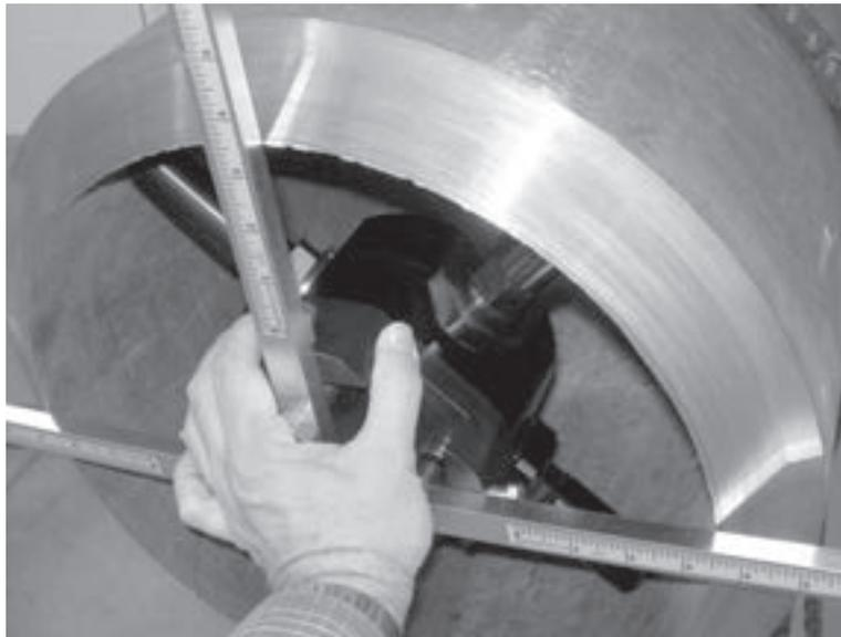
*Abbildungen 5-16. Drücken Sie das Spanngehäuse in das Rohr, bis alle vier Arme der Ausrichtungslehre das Rohrende berühren.*
